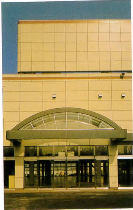
ホームセンターコーナン泉北店 ■所在地/大阪府堺市 ■設計/南海総合設計 ■施工/阪南建設㈱
